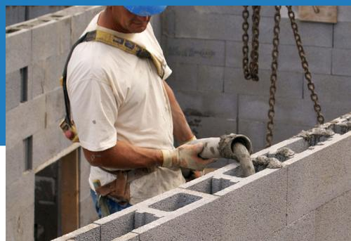
Blocs de coffrage calibrés en granulats courants, posés à sec, à remplir de béton pour la réalisation de maçonnerie d'élévation et de soubassement, pour le logement individuel et collectif.
