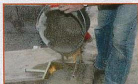
Mise en place du mortier-colle dans le rouleau sans truelle. La colle doit être suffisamment épaisse pour ne pas couler.
