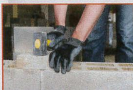
Utilisez un maillet en caoutchouc ou une massette avec chevron pour éviter les fissurations ou éclatements.
