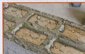
Appliquez sur une surface propre et dépoussiérée. Ne posez pas le rouleau au sol ou sur une surface sale. Respectez le guide afin de ne pas écraser le joint. Tirez le rouleau en position inclinée. Respectez une épaisseur de 10 mm. En cas de pose et dépose, encollez à nouveau.
